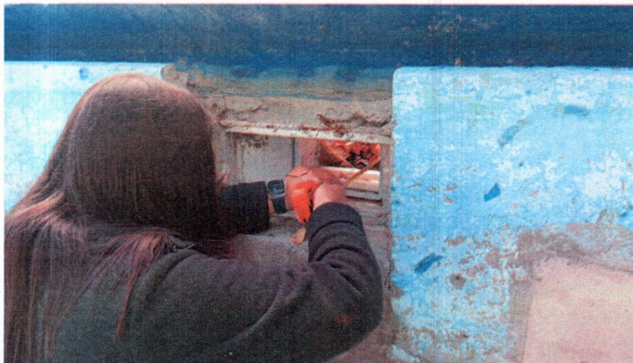
Figura 6: Salida a terreno para realizar levantamiento existente
