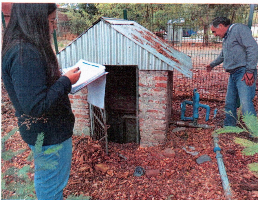
Figura 7: Visita a terreno sector pozo de abastecimiento
