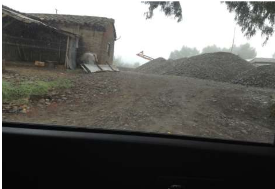
Fotografía N°10: Planta de áridos en sector La Balsa
