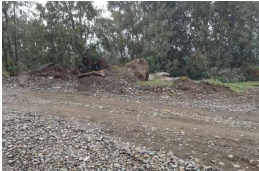
Fotografía N°3: Sector en que se instaló cierre del camino con grandes bolones que se aprecian a un costado.
